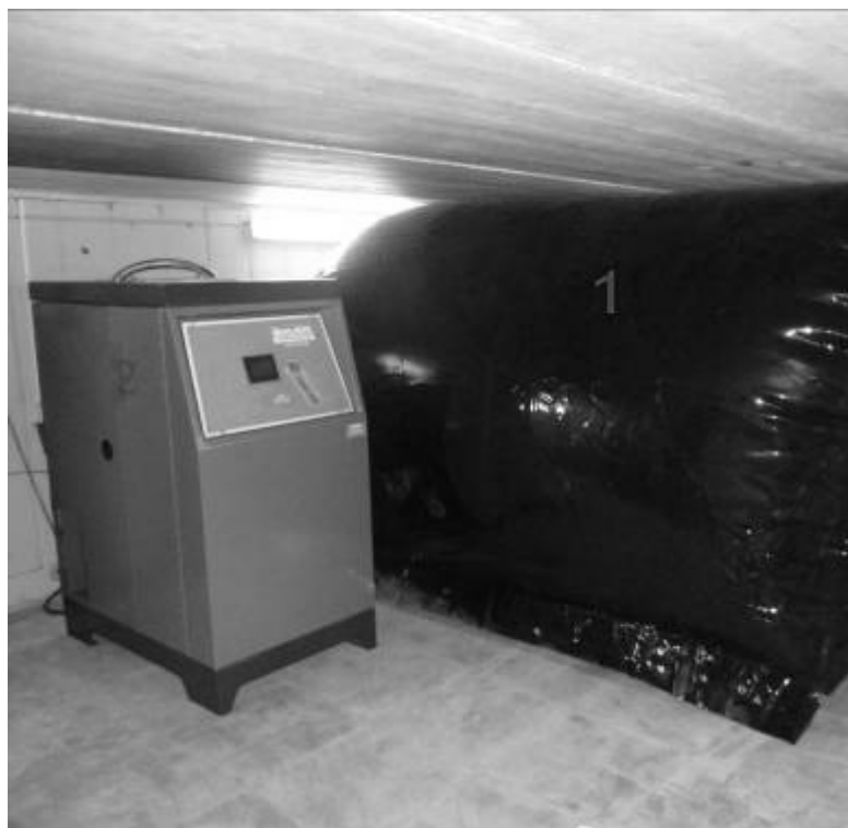
Рисунок 1.10 Элементы системы сбора гелия ЦКП ИФМ РАН. На рисунке: 1-Газгольдер объемом 8.5 м 3 , 2- компрессор высокого давления (до 150 атм).
